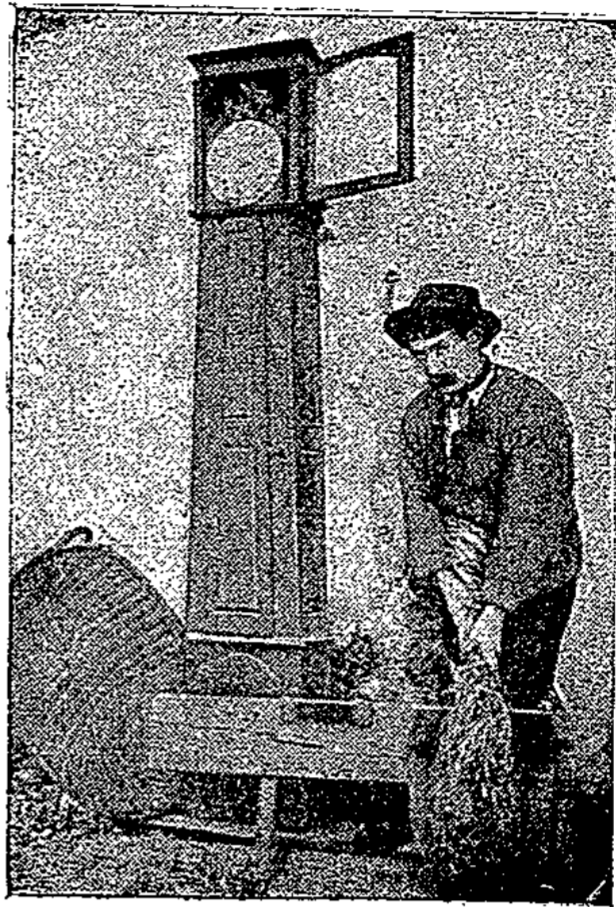
Fig. 9. — Peignage du chanvre ; les sérans (peignes) sont fixés sur une planche portée par des montants fixés au plancher ; tout l'instrument s'appelle séranoir ; à gauche, horloge du xvii e siècle, fabrication locale.
